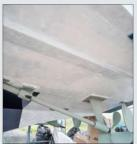
B Comme la surface décapée reste parfaitement sèche et lisse, il est paraitement seche et lisse, il est possible d'appliquer immédiatement un primaire ou un enduit préalable à une nouvelle finition. Dans la pratique, le nettoyage des 48 mètres carrés des œuvres vives a demandé une quinzaine d'heures de travail et 700 kg de carboglace. Un devis préalable est indispensable, sur la base d'un prix moyen d'une soixantaine d'euros par mètre carré.
